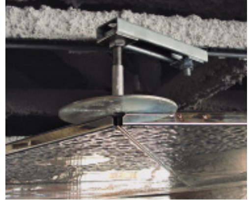
Das eigens entwickelte Befestigungssystem ermöglicht eine flexible Aufnahme der Paneele.
