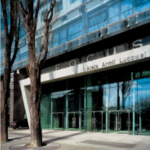
Der Haupteingang an einer viel befahrenen Straße liegt unterhalb der Doppelglasfassade an der Südseite.
