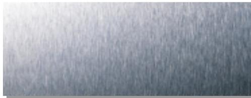
*Das optische Erscheinungsbild geschliffener Oberflächen hängt von der werksseitigen Oberfläche und der Korngröße des Schleifbandes ab: Korn 180 (oben) und Korn 240 (unten).*
