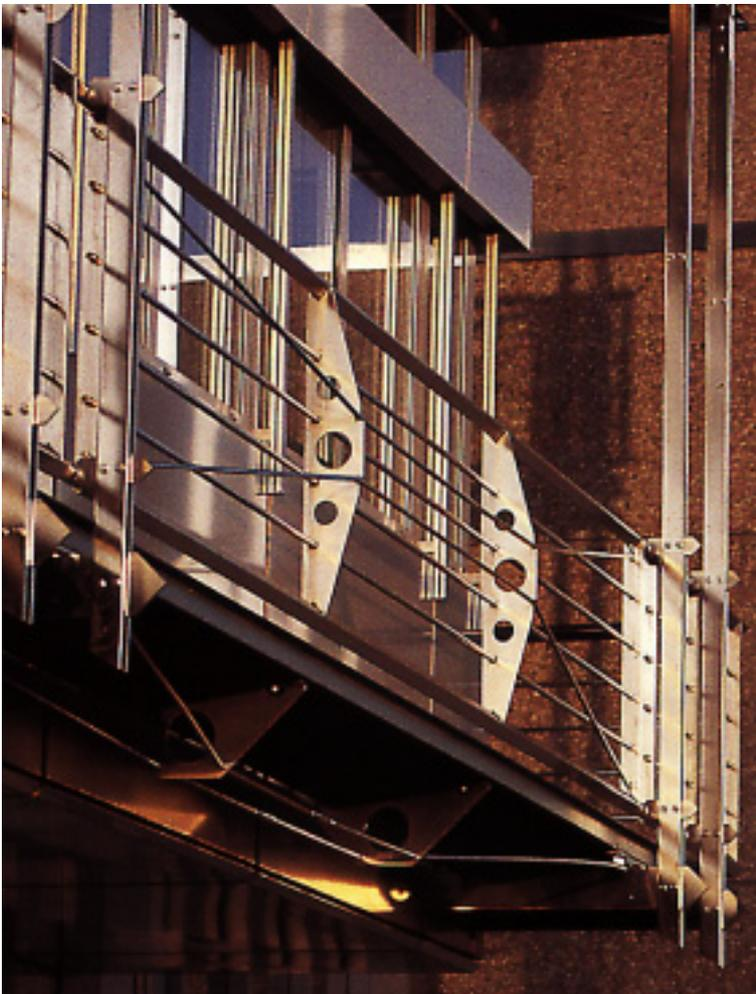
*Die Edelstahl-Bauteile an diesem Gebäude wurden elektropoliert, um an einem Standort mit Industriatmosphäre die Voraussetzungen für dauerhafte Korrosionsbeständigkeit und gutes Aussehen zu schaffen.*
