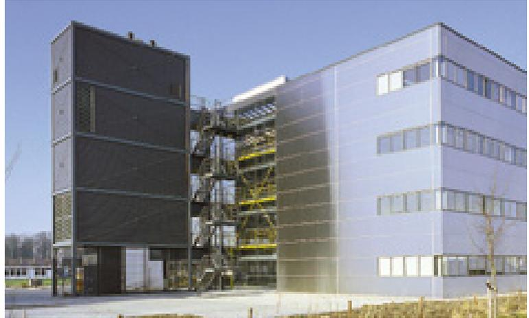
Los dos edificios de 4 plantas con estructuras de armazón – esqueleto de hormigón están unidos por un atrio vidriado que contiene todas las rutas de acceso verticales y horizontales, así como las cocinas y servicios sanitarios. Las zonas de oficinas flexibles, que se pueden dividir con facilidad, se han dejado para firmas de computadoras y software pequeñas y de tamaño medio.
