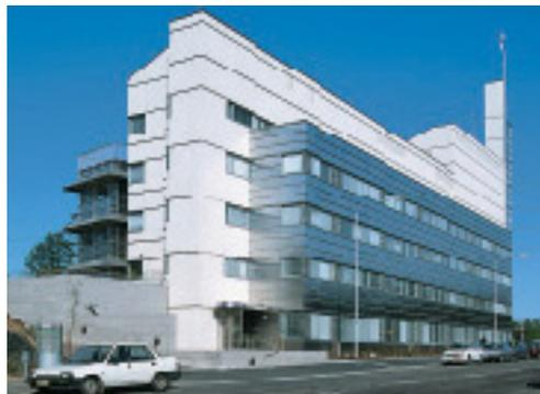
*El revestimiento de cerámica blanca del bloque central transmite una impresión de claridad y contrasta muy atractivamente con la fachada de acero inoxidable.*
