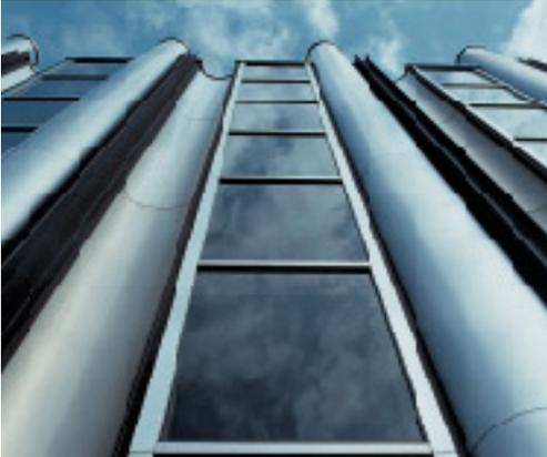
*Los conductos de los servicios están instalados en el interior de los elementos de la fachada semicircular.*
