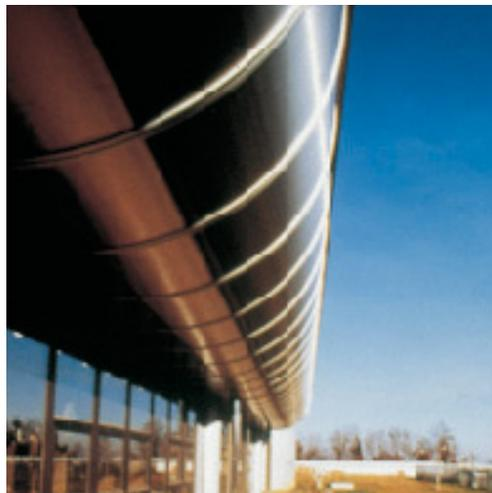
*En el piso superior, el drenaje del agua de la lluvia se disimula detrás del revestimiento de acero inoxidable.*
