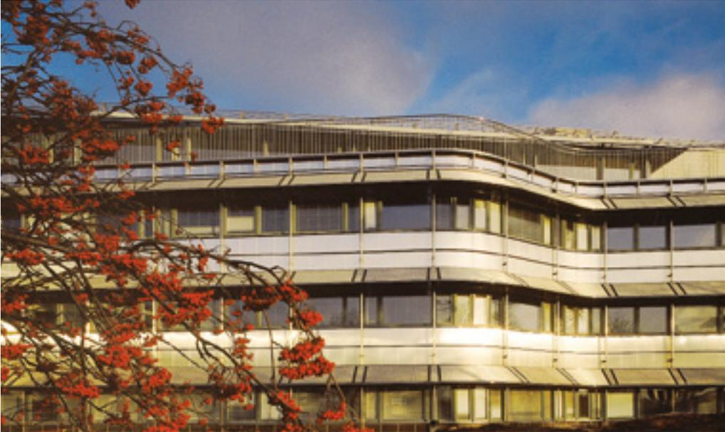
*Los elementos de acero inoxidable de la fachada redondeada orientada al suroeste tienen acabados superficiales diferentes: los manguitos y las rejillas de las persianas están chorreadados con bolas; los marcos tubulares están pulidos y los paneles del revestimiento tienen un acabado esmerilado grueso.*
