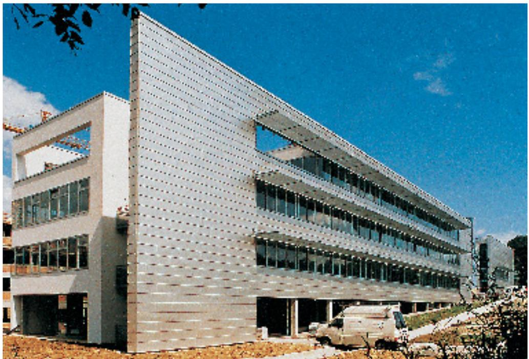
*Las filas de ventanas horizontales y los elementos de las pantallas solares, junto con las uniones plegadas del revestimiento, acentúan la longitud de este bloque, que se interrumpe con la fachada acristalada de la zona de entrada.*
