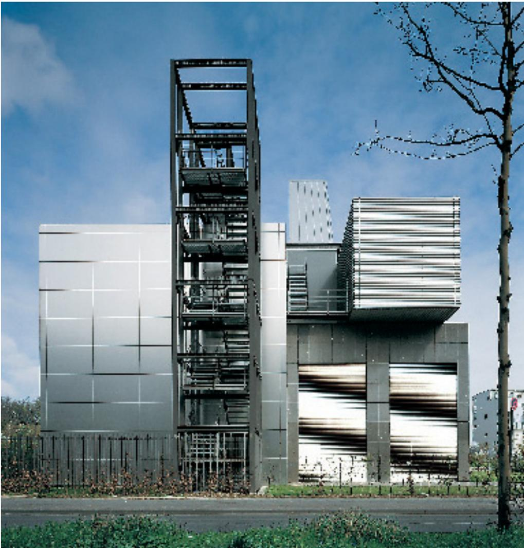
*Las diversas áreas funcionales se distinguen por el uso de revestimientos de fachadas de diversas clases, fijadas sobre el hormigón armado de la estructura.*
