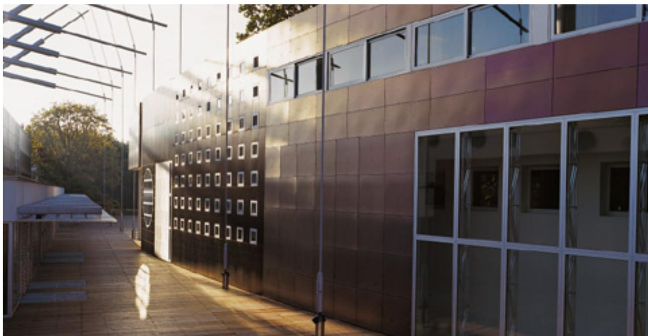
El C3T es un centro de investigación especializado en el desarrollo de nuevas tecnologías para el transporte terrestre. Para distinguir las diferentes secciones del edificio, se utilizó hormigón pintado de azul oscuro en la zona de oficinas y talleres técnicos, y de paneles de acero inoxidable plegado para la sala de pruebas.
