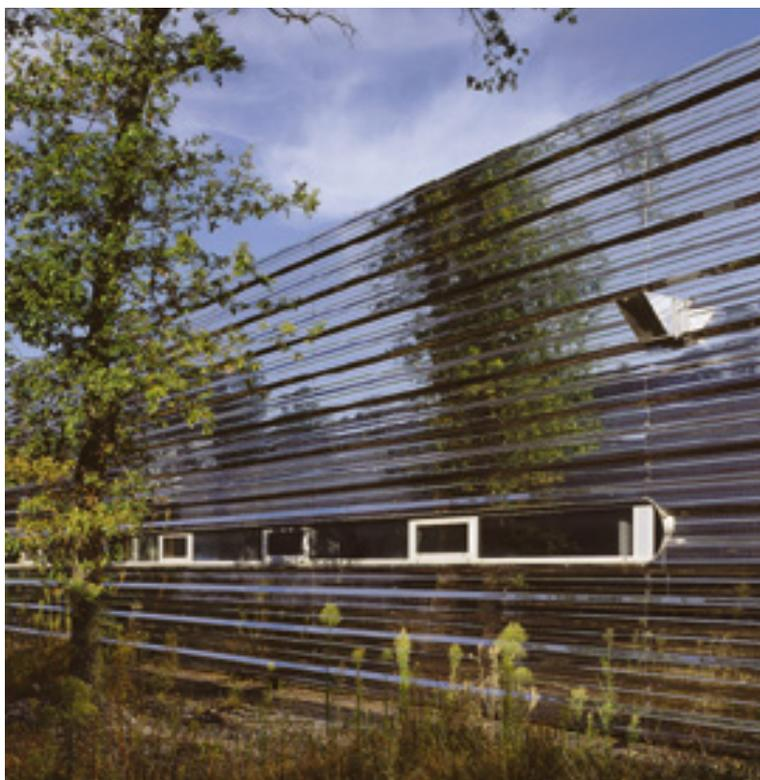
En esta planta se fabrican puertas de acero inoxidable además de tanques para productos alimenticios y químicos. El proceso del acero inoxidable en las labores internas se refleja en la apariencia exterior del edificio, para cuyo revestimiento se utilizan chapas de metal corrugadas en la sección trapezoidal – familiar en la industria de la construcción.
