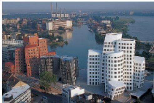
del esquema, con fachadas con tres tipos de materiales diferentes, crean una silueta extremadamente original. La sección más pequeña del complejo, situado en la mitad, tiene una fachada de paneles de acero inoxidable en el que se reflejan la fachada sur de ladrillo de color terracota, y la del norte, que
