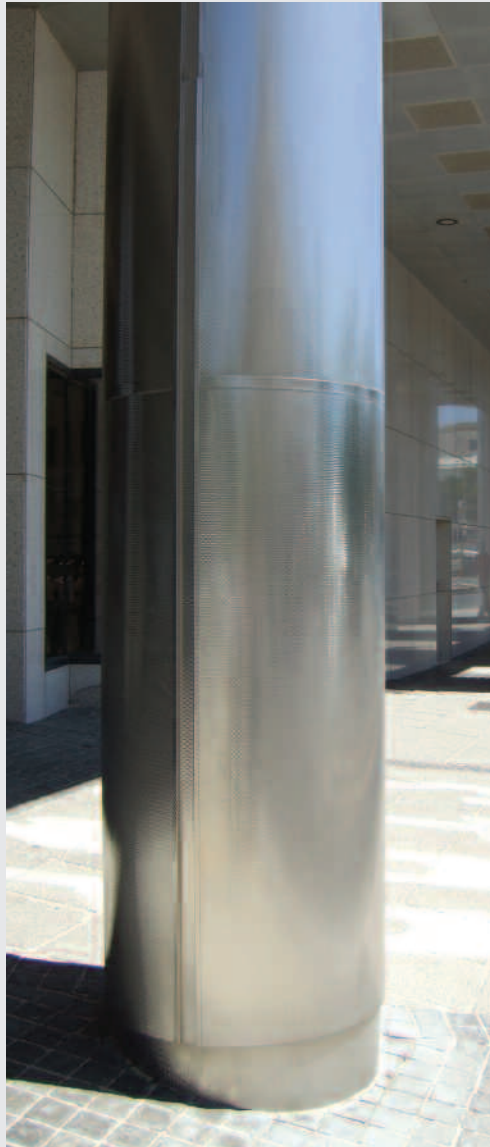
Getextureerd roestvast staal verzekert vlakke oppervlakken en verbergt deuken op doeltreffende wijze.
