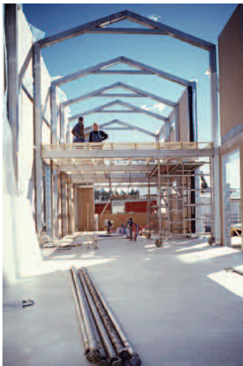
Roestvast stalen constructies kunnen veilig en in een minimaal tijdsbestek geplaatst worden, uitgaande van een goed gedocumenteerde uitvoeringsprocedure.
