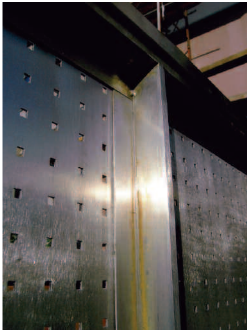
Plaatselijke roestvorming werd veroorzaakt door ijzerdeeltjes achtergebleven op een schuurmiddel (schijf) dat voordien voor koolstofstaal gebruikt werd (links). Indien roestvorming door ijzerdeeltjes optreedt, kan het verholpen worden door ter plaatse na te beitsen (rechts) [12]
