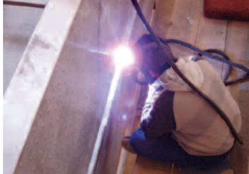
Lassen van een roestvast stalen beplating in een zwembad
