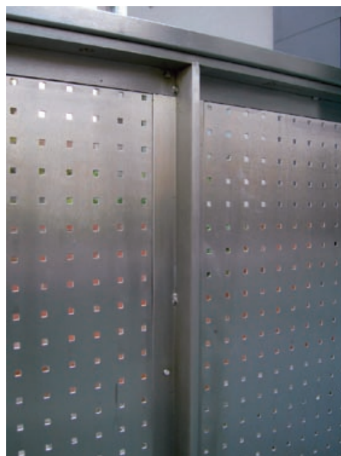
Des tâches localisées de rouille sont causées par des particules de fer d'un disque, qui avait été précédemment utilisé sur de l'acier au carbone (à gauche). Lorsqu'une contamination ferreuse s'est produite, elle peut être enlevée par un décapage sur chantier (à droite) [12].
