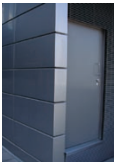
L'effet de raidissage des bords garantit une forme visuelle plane.
