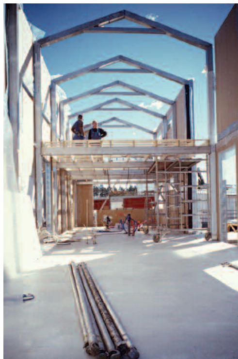
Auf der Grundlage einer expliziten Bauablaufplanung lassen sich Konstruktionen aus nichtrostendem Stahl ergebnissicher und schnell erstellen.
