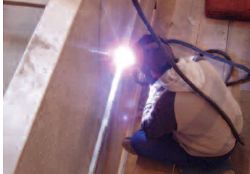
Baustellenschweißung am Beispiel einer Schwimmbeckenaus- kleidung
