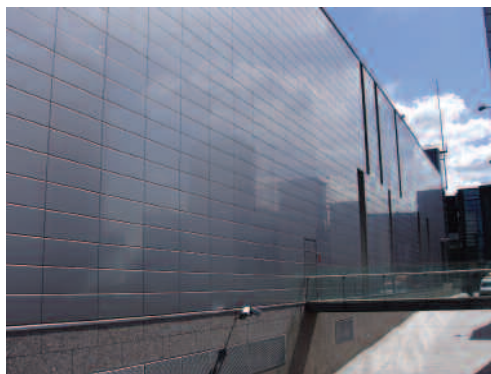
Eine einheitliche Oberflächenwirkung lässt sich erzielen, wenn durchgängig nichtrostender Stahl desselben Herstellers und aus demselben Produktionsdurchgang eingesetzt wird.
