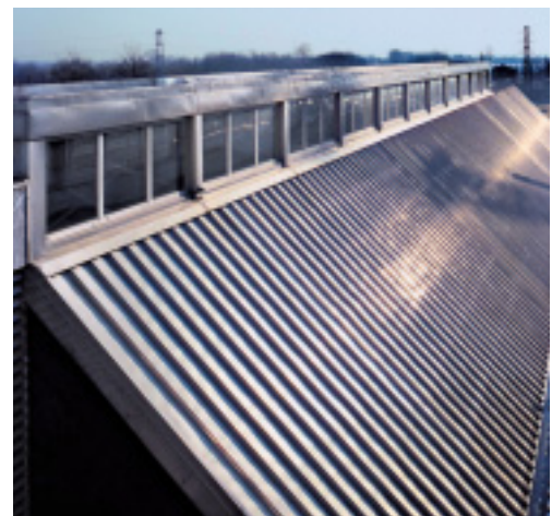
La claraboya, recubierta de acero inoxidable, deja pasar la luz natural a una sala de exposiciones prácticamente sin ventanas.
