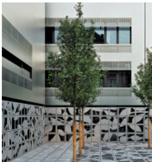
Las pantallas de funcionamiento eléctrico cierran suavemente para formar una capa de acero inoxidable monopieza.
