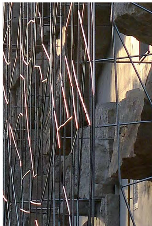
*Le tuteur fait de tubes d'acier inoxydable de 20 mm est fixé à la façade au moyen de plaques de support.*
