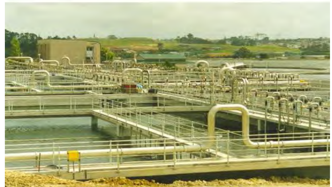
Planta de tratamiento de aguas residuales de North Shore Auckland, Nueva Zelanda
