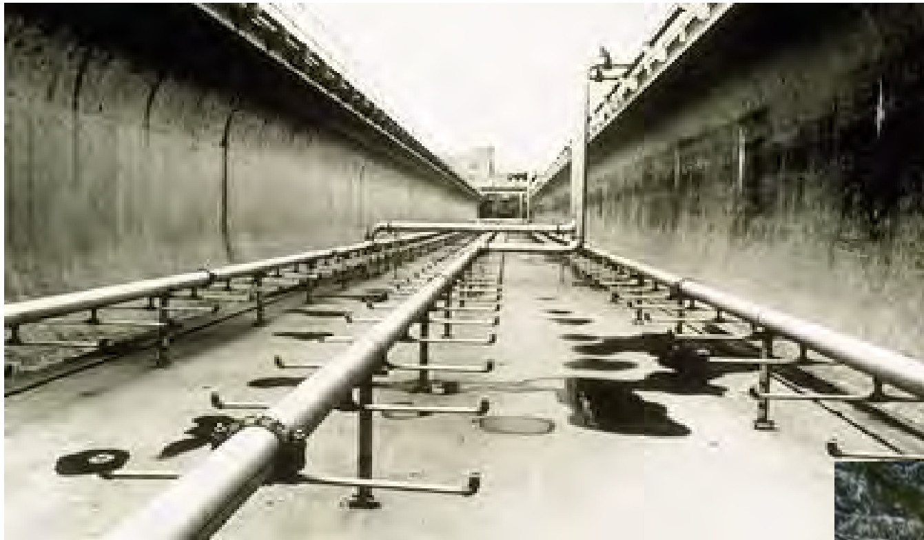
Tubería de acero inoxidable 304 después de limpiar el depósito ,en EE. UU.
