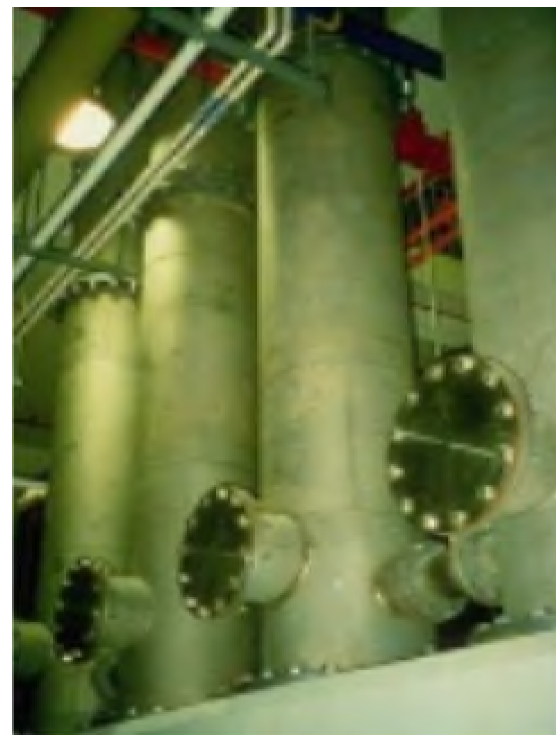
Torres de mezcla de cloro / ozono T- 316L-EE. UU.
