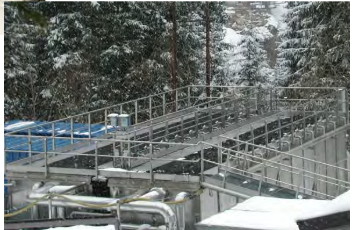
Dos contenedores de acero inoxidable con tanques de aireación.
