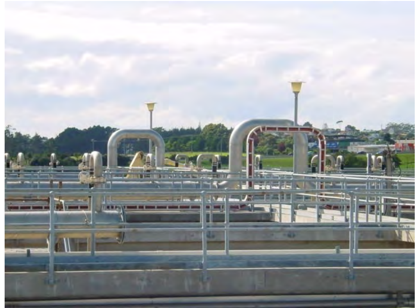
Tipo dúplex 2205 Tubería de transferencia de biogás en planta de tratamiento de aguas residuales en Nueva Zelanda
