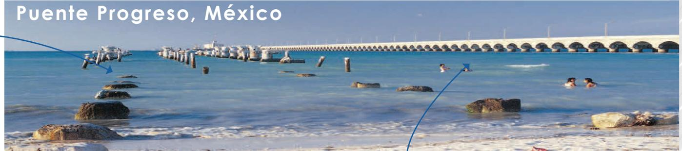
*Puente construido con barra de acero inoxidable en 1930*
