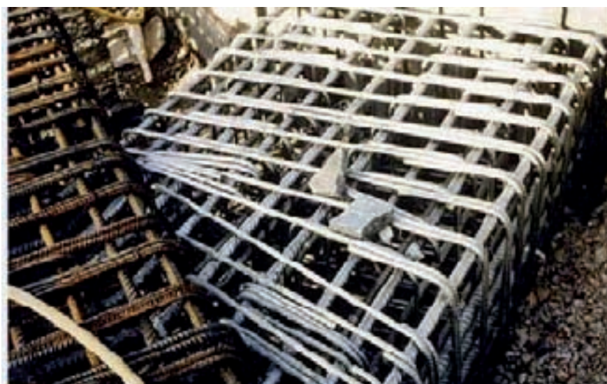
Figura 5.61. Solape de armaduras de acero al carbono con armaduras de acero inoxidable en el refuerzo del puente Highnam en el Reino Unido
