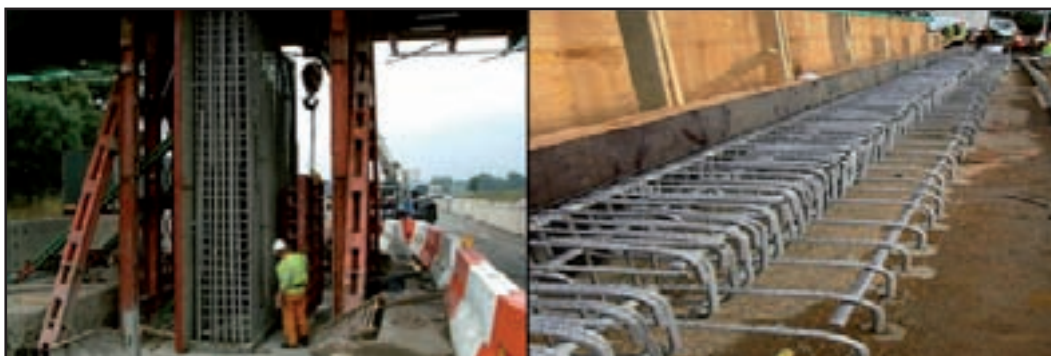
Figura 5.64. Empleo de armadura de acero inoxidable en reparación de puentes. Izda) sustitución de pilares, dcha) reparación de aceras.
