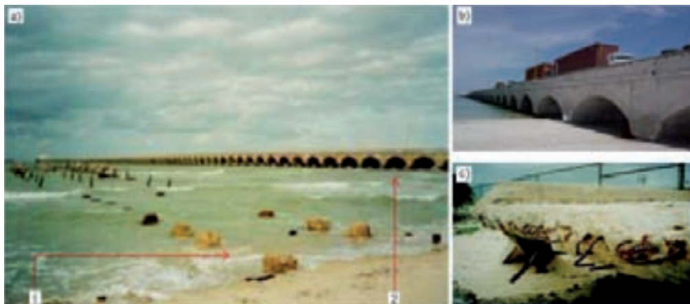
Figura 5.63. Puerto Progreso (México) casos: a) vista general mostrando el Puente completamente destruido usando armadura de acero construido en 1972 (1) y (2) Puente construido en 1960 usando armadura de acero inoxidable; b) Vista de cerca de restos del Puente (1); c) Vista de cerca del puente (2) (Arminox 1999 [128]).
