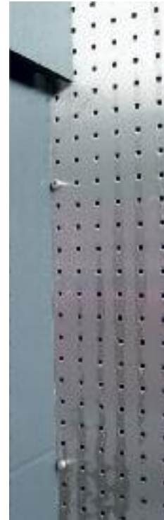
Figura 11: Para prevenir la corrosión galvánica, sólo se deben instalar sujeciones de acero inoxidable en los paneles de acero inoxidable.
