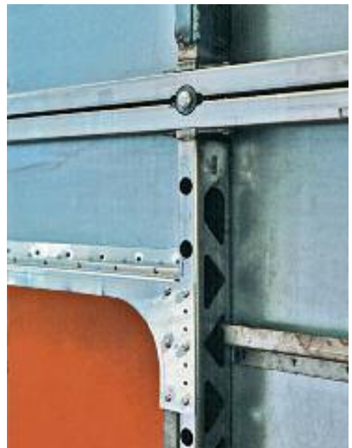
Figura 24: En los laterales de un tren de cercanías, la estructura y los paneles exteriores son de distintos tipos de acero inoxidable. Como todos ellos tienen potenciales idénticos, no se puede producir corrosión galvánica.
