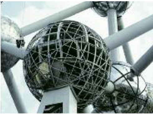
Figura 17: Sujeción de los paneles exteriores de acero inoxidable a una estructura de acero al carbono en el Atomium, Bruselas
