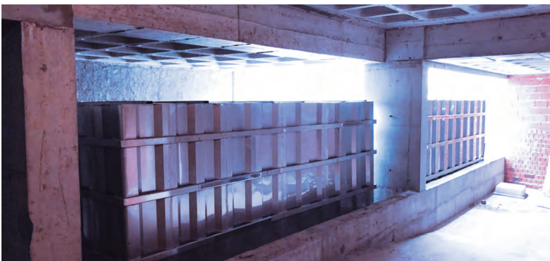
Figura 3 instalação no trabalho
