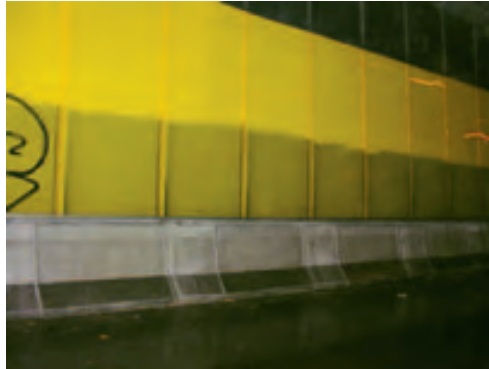
Trots ogynnsamma förhållanden inne i tunneln kunde ingen korrosion påvisas vid rengöringen. Foto: Centro Inox, Milan (I)
