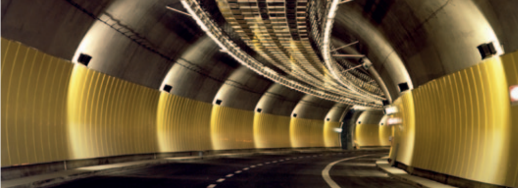
Para evitar deslumbramientos, se utiliza acero inoxidable recubierto en bobina, para los revestimientos resistentes a la corrosión en túneles. Fotografía: ThyssenKrupp Acciai Speciali Terni (IT)
