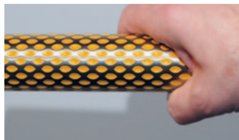
El color hace que las barandillas de acero inoxidable sean más visibles para personas con discapacidad visual. Fotografía: Rimex Metals, Enfield (GBR)
