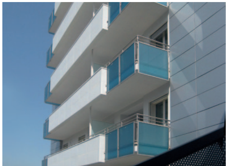
El acero inoxidable recubierto en bobina puede doblarse, por ejemplo, en los elementos de fachada. Fotografía: Centro Inox, Milán (IT)
