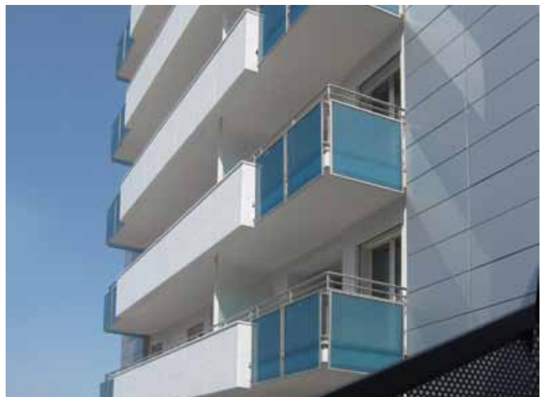
Maalipinnoitettu ruostumatton teräslevy soveltuu taivutukseen – esimerkiksi julkisivuelementeiksi. Kuva: Centro Inox, Milano (Italia)
