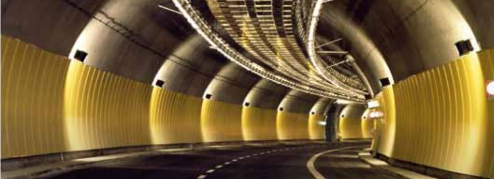
Maalipinnoitettua ruostumatonta terästä käytetään heijastumisen estämiseksi korroosionkestävissä tunnelin seinälevyissä. Kuva: ThyssenKrupp Acciai Speciali Terni, Terni (Italia)
