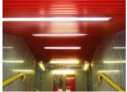
Punaiseksi värjätty ruostumaton teräspinta koristaa Piazzale Carlo Maciachini metroasemaa Milanossa. Kuva: Centro Inox, Milano (Italia)
