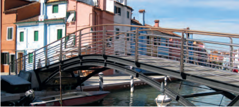
Diese Fußgängerbrücke aus nichtrostendem Stahl in Venedig wurde schwarz lackiert, um sie dem historischen städtebaulichen Umfeld anzupassen. Fotos: IMO, London (UK)
