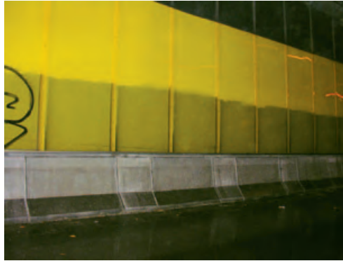
Nach der Reinigung zeigt sich, dass die Tunnelwände trotz der sehr aggressiven Atmosphäre frei von Korrosionerscheinungen sind. Foto: Centro Inox, Mailand (I)
