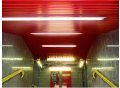
Ein ausdrucksstarkes Rot wurde für die Edelstahl-Deckenpaneele der Mailänder U-Bahn-Station Piazzale Carlo Maciachini ausgewählt. Foto: Centro Inox, Mailand (I)
