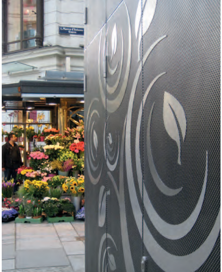
Verkaufsstände, die mit elektrolytisch gefärbtem Edelstahlblech bekleidet sind, finden sich im Zentrum von Wien.
