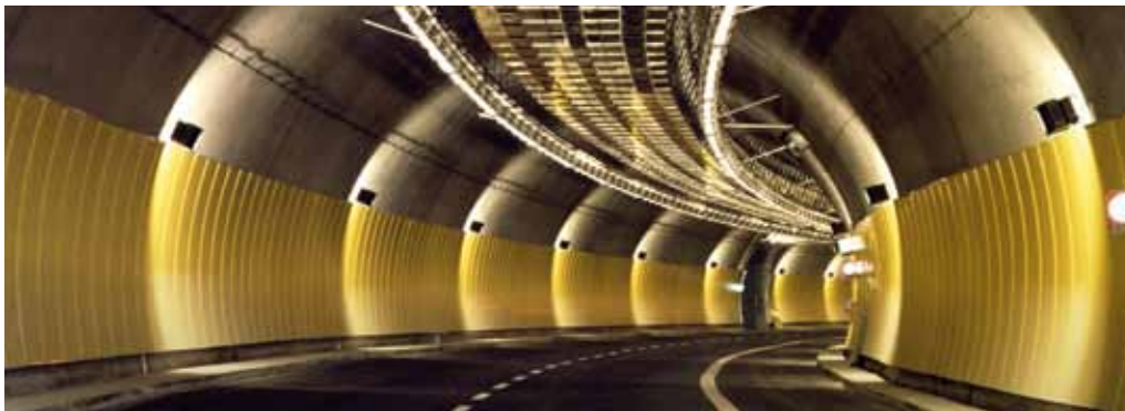
Na korozně odolné obložení tunelů se používá korozivzdorných ocelí povlakovaných ve svitku pro jejich neoslbný povrch. Fotografie: ThyssenKrupp Acciai Speciali Terni, Terni (I)
