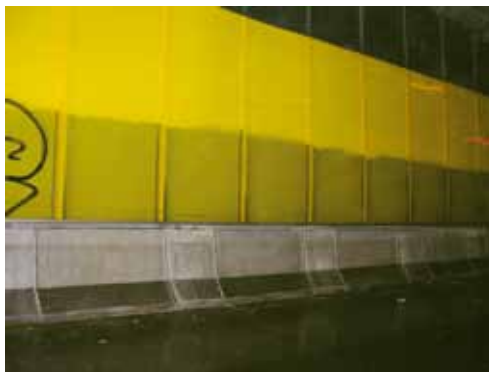
Čištění bočních stěn přes velmi nepříznivé podmínky v tomto tunelu neodhalilo žádnou korozi. Fotografie: Centro Inox, Milan (I)
