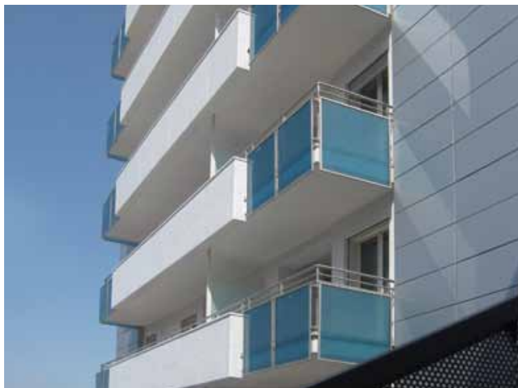
Plech z korozivzdorných ocelí povlakované ve svitku je možno ohýbat – například při tvarování fasádových panelů. Fotografie: Centro Inox, Milan (I)
