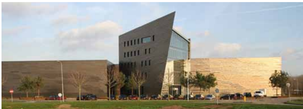
Barevná korozivzdorná ocel zvládnouje trojrozměrné členění budovy Banca S. Marino. Fotografie: Steel Color, Pescarolo Ed Uniti (I)
