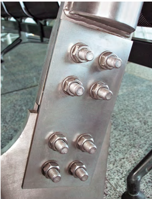
Díly z korozivzdorné oceli je třeba spojovat zase jen šrouby a svorníky z korozivzdorné oceli.
