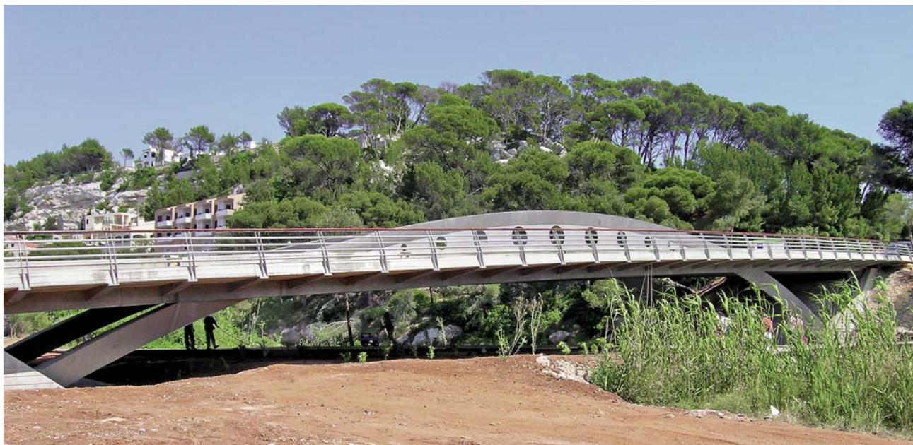
*Los puntales inclinados entre los extremos exteriores de los arcos y las vigas longitudinales absorben las fuerzas horizontales de los arcos, aliviando de este modo la presión sobre los cimientos.*
