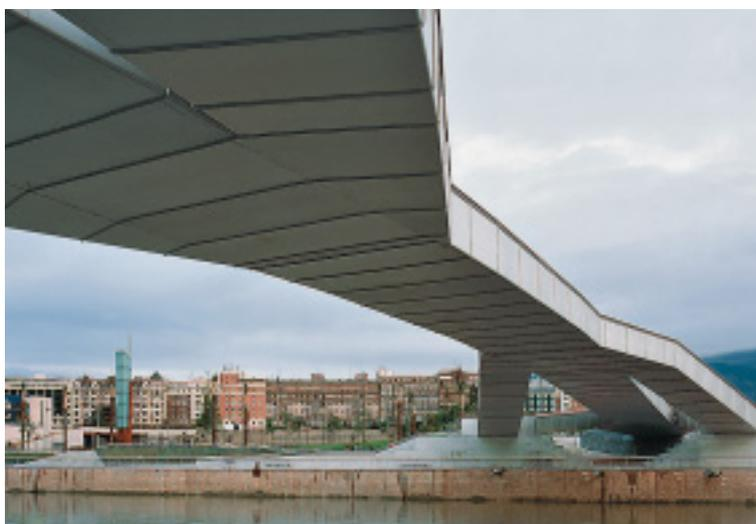
El puente de 142,2 m se compone de muchas secciones individuales, como se aprecia en las juntas visibles. La caja en sí se divide en tres vanos, y en cada extremo el acceso al puente se realiza a través de cuatro rampas, que además apuntalan la estructura. Las rampas opuestas constituyen caballetes
