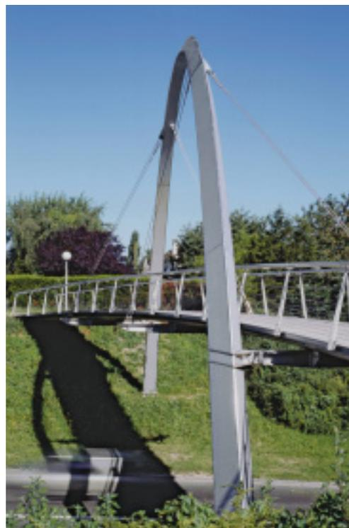
*La sección triangular del arco se estrecha desde las bases hasta la cúspide.*
