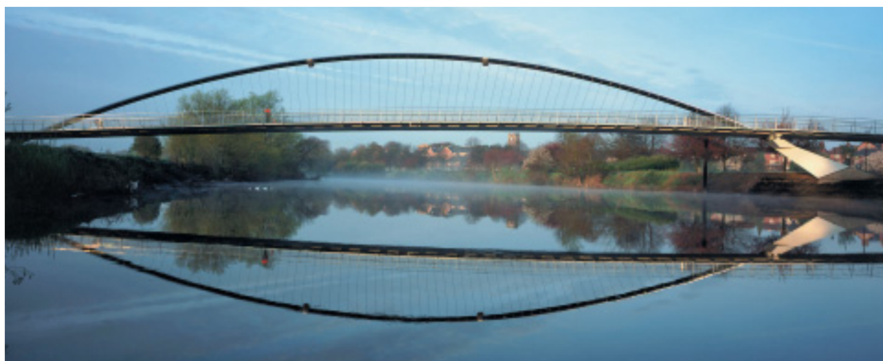
Ruostumaton teräskaari, jonka jänneväli on 80 metriä, on kallistettu 50 astetta pystysuunnasta.
