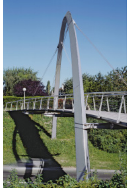
Poikkileikkaukseltaan kolmion muotoinen kaari kapenee perustuksilta lakipistettään kohden.
