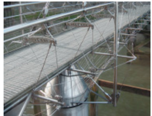
Ruostumaton teräsköyristö kannattaa kääntyvää jalankulkusiltaa.
