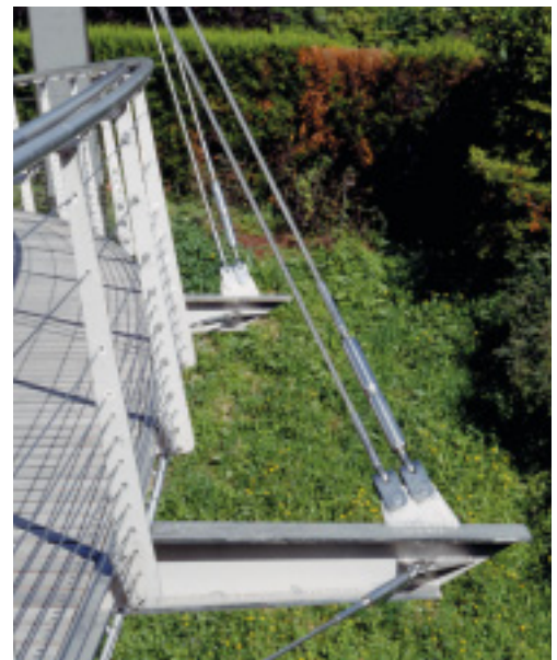
Pareittain kiinnitetyt vetotangot yhdistävät poikkipalkit kaareen.
