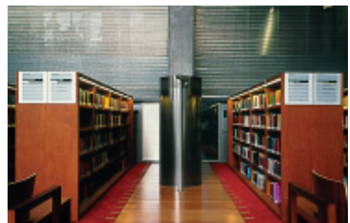
Au mur des salles de lecture de recherche, la maille d'inox cache des galeries de circulation sans les occulter, pour le confort de leurs utilisateurs.
