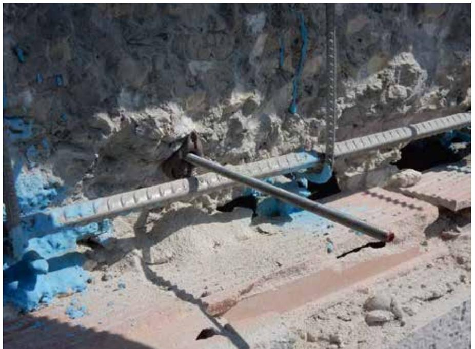
Foto 37.Preparación de esperas para anclajes de registro
