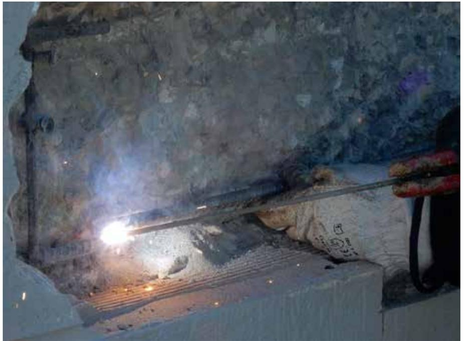
Foto 19. Soldadura barra existente con barra inoxidable
