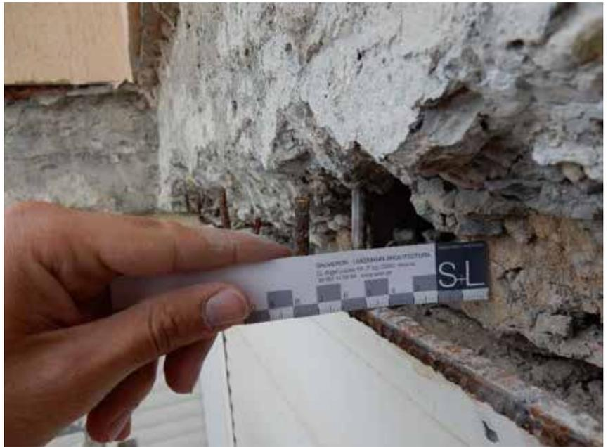
Fig. 2 Picado hasta dejar espacio entre hormigón y armadura
