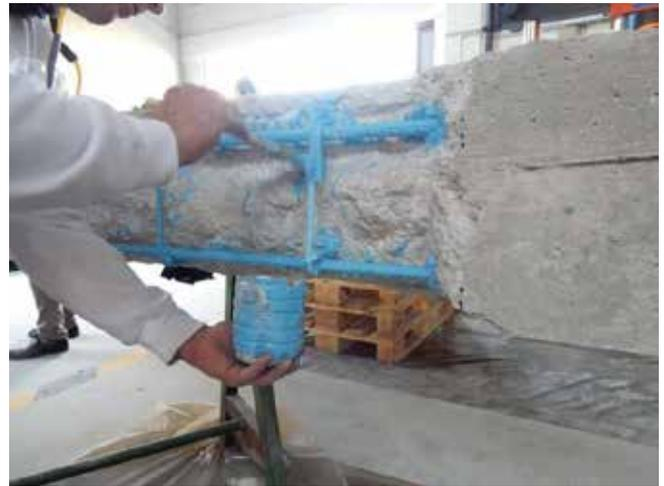
Foto 28. Protección anticorrosión en zona de estribos
