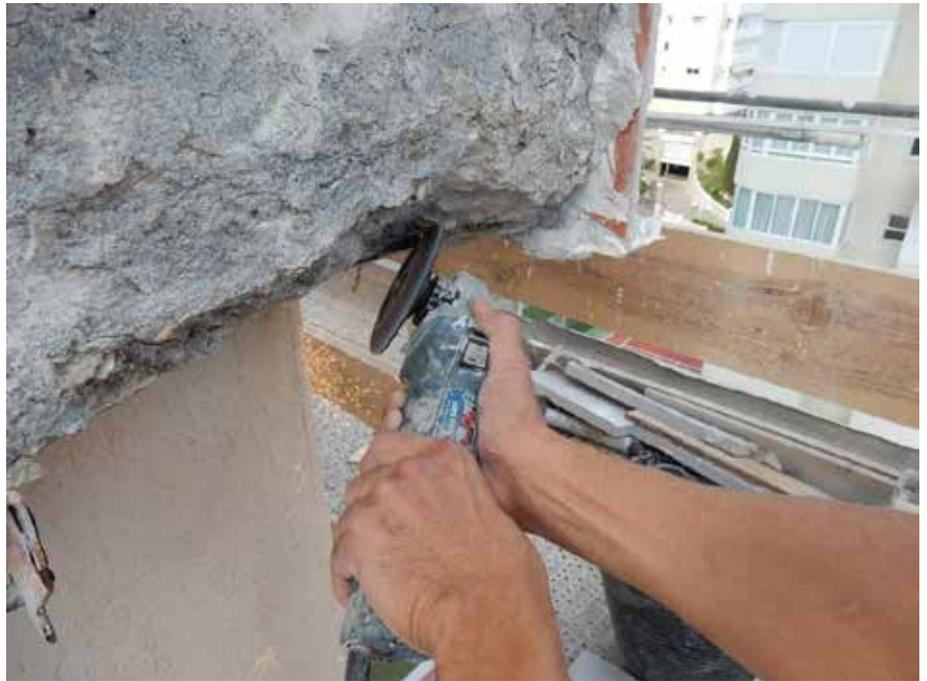
Lijado de armadura para llegar a sustrato sano
