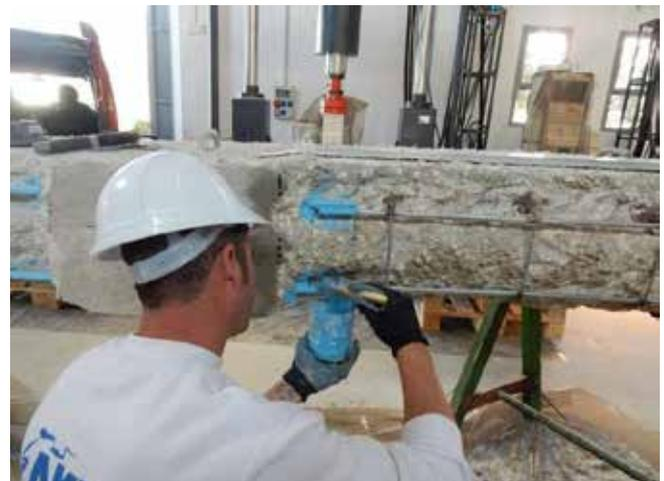
Foto 72. Inicio aplicación protección anticorrosión
