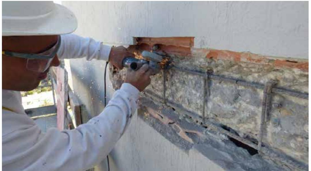
Foto 11. Corte de estribos existentes
