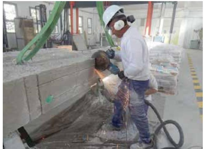
Foto 89. Corte del hormigón
