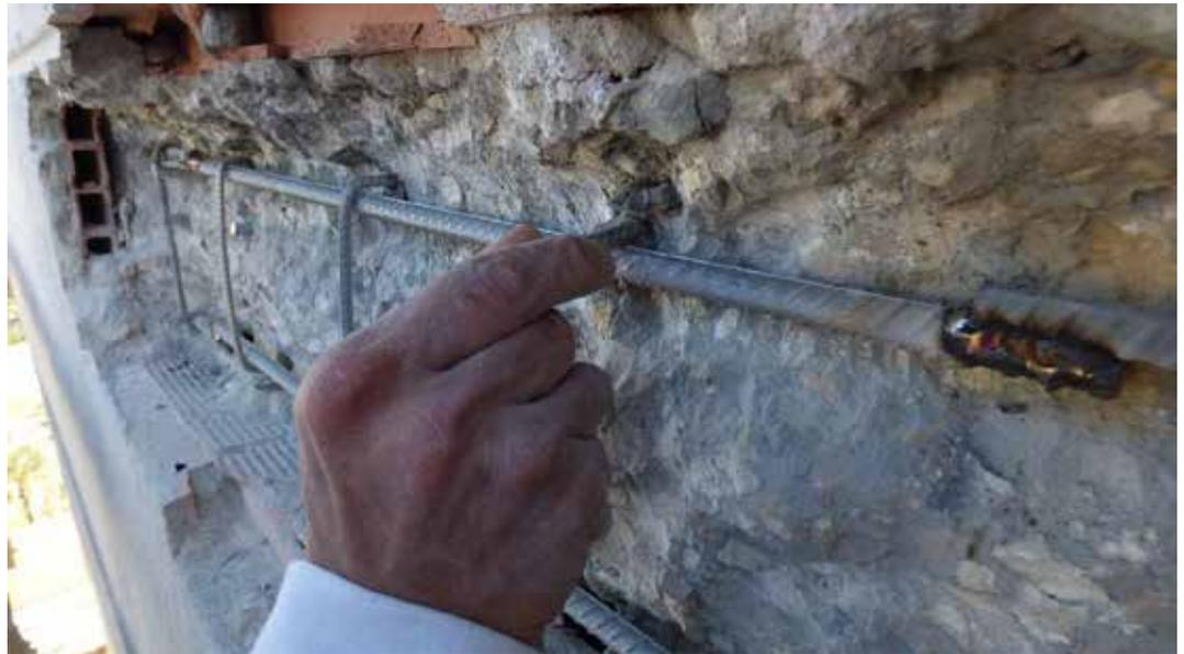
Foto 27. Pruebas de colocación de estribos
