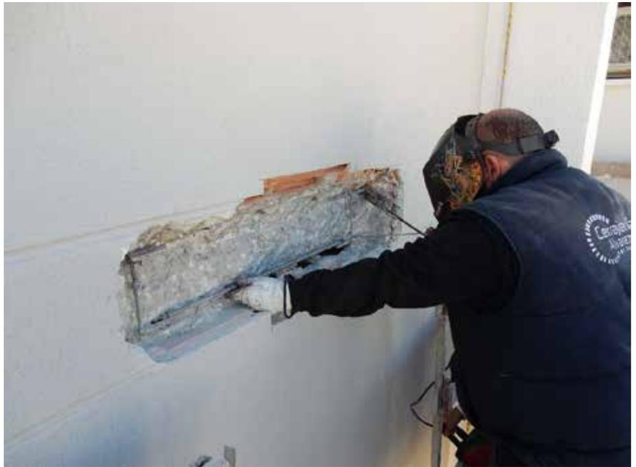
Foto 17.Preparación de soldadura a pie de obra
