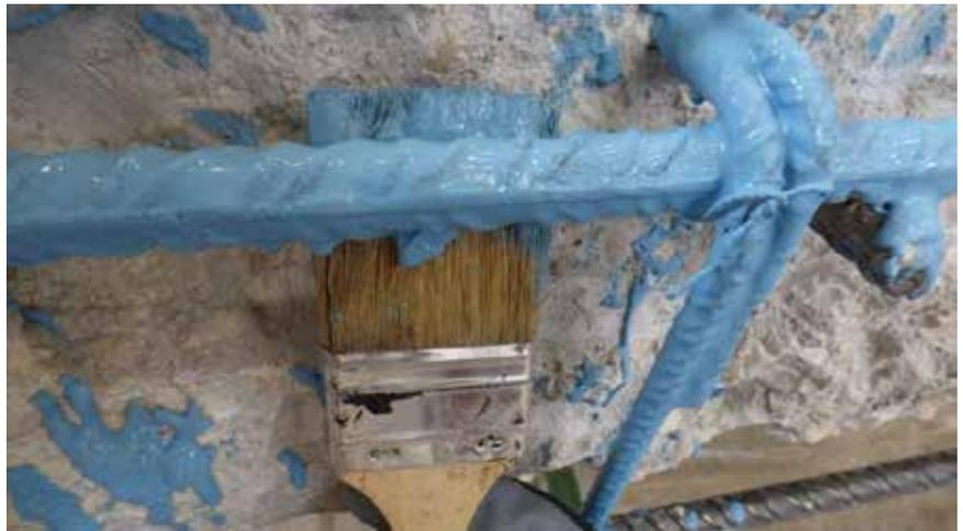
Foto 23. Protección en la parte trasera de las armaduras
