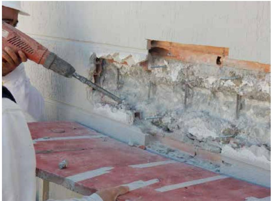
Foto 1. Picado frente de forjado y forrado de ladrillo
