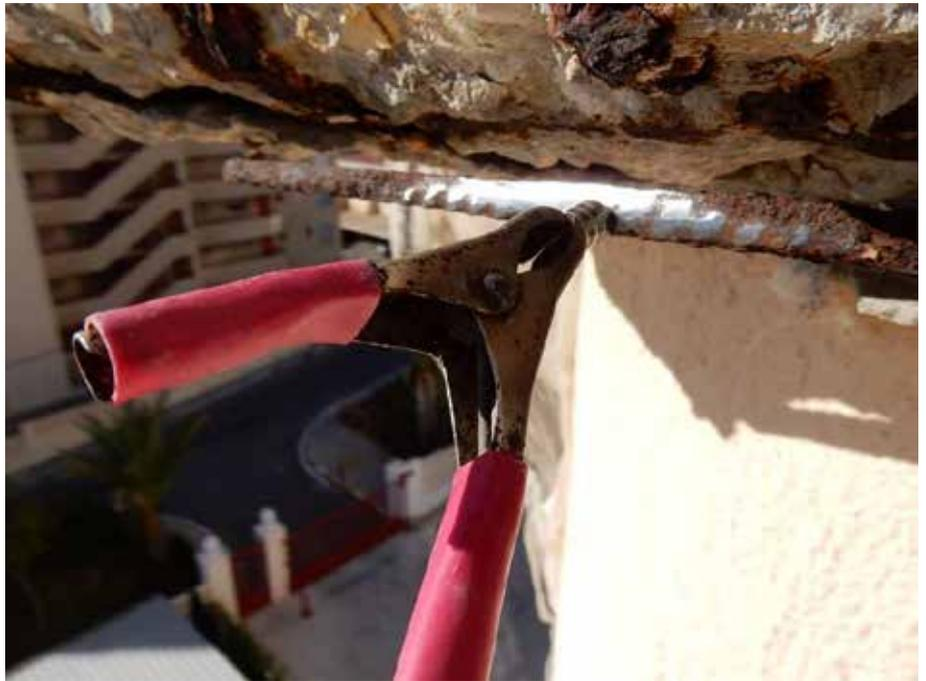
Colocación de pinza para paso de corriente
