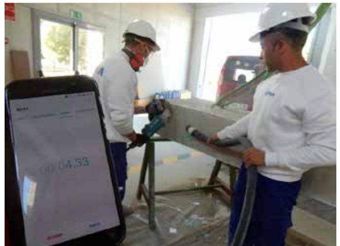
Foto 80. Corte del hormigón
