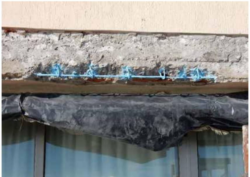
Fig. 4 Protección de armadura con pintura anticorrosión
