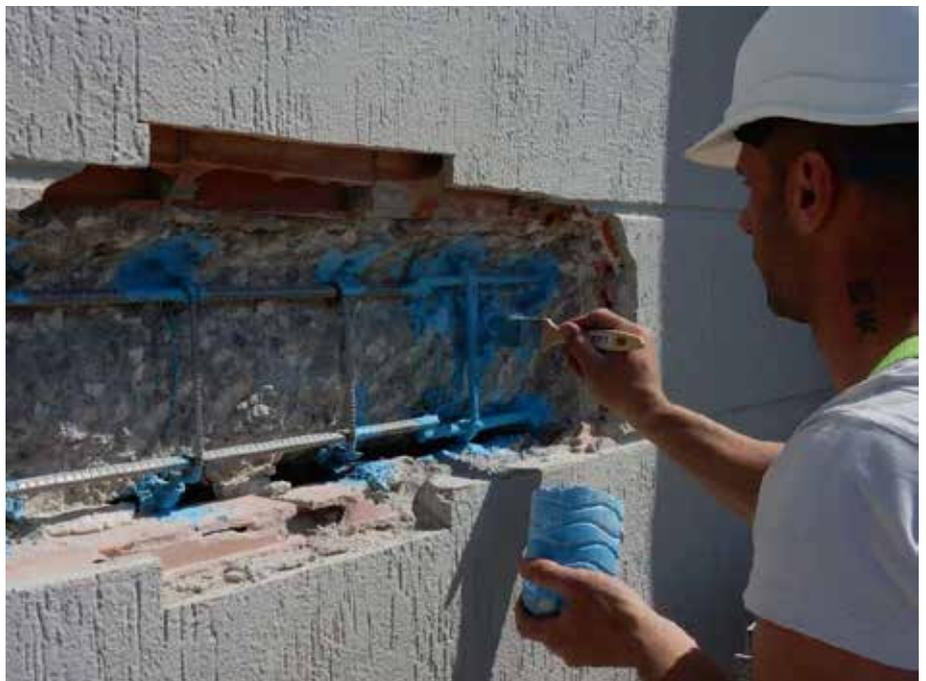
Foto 30. Protección y puente de unión
