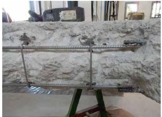
Foto 68. Resultado tras inyección y colocación estribos
