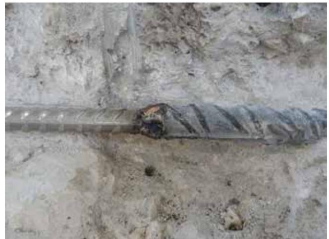
Foto 114. Detalle de la soldadura
