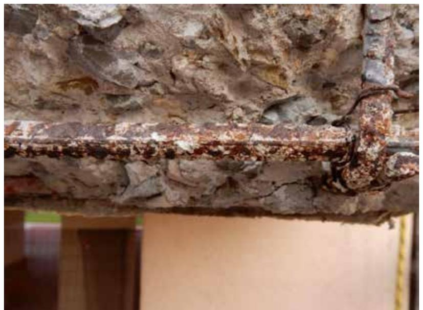
Fig. 3 Grado de afección de armadura descubierta
