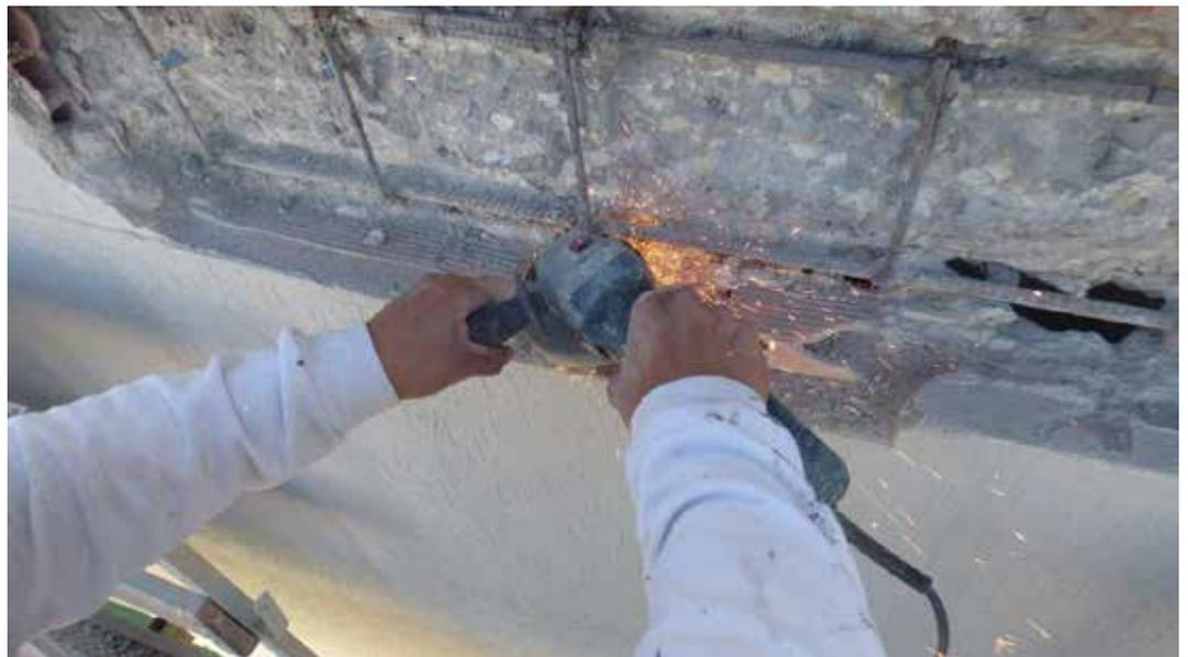
Foto 12. Corte de estribos existentes
