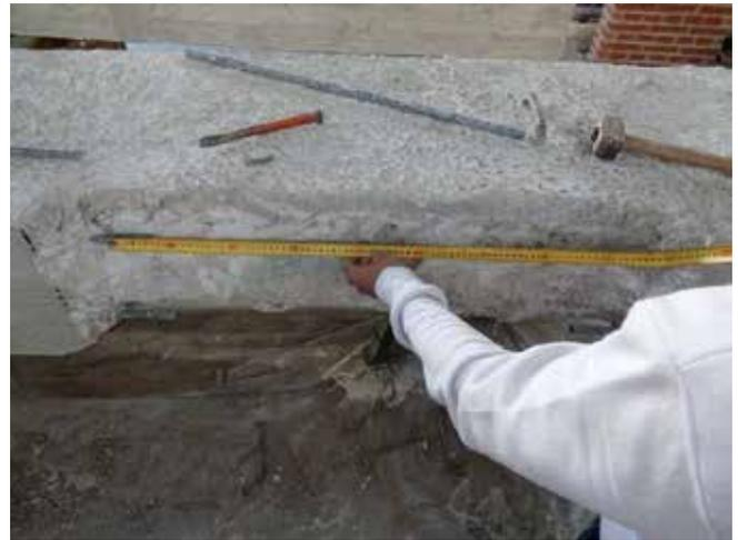
Foto 43. Medición y replanteo nueva barra
