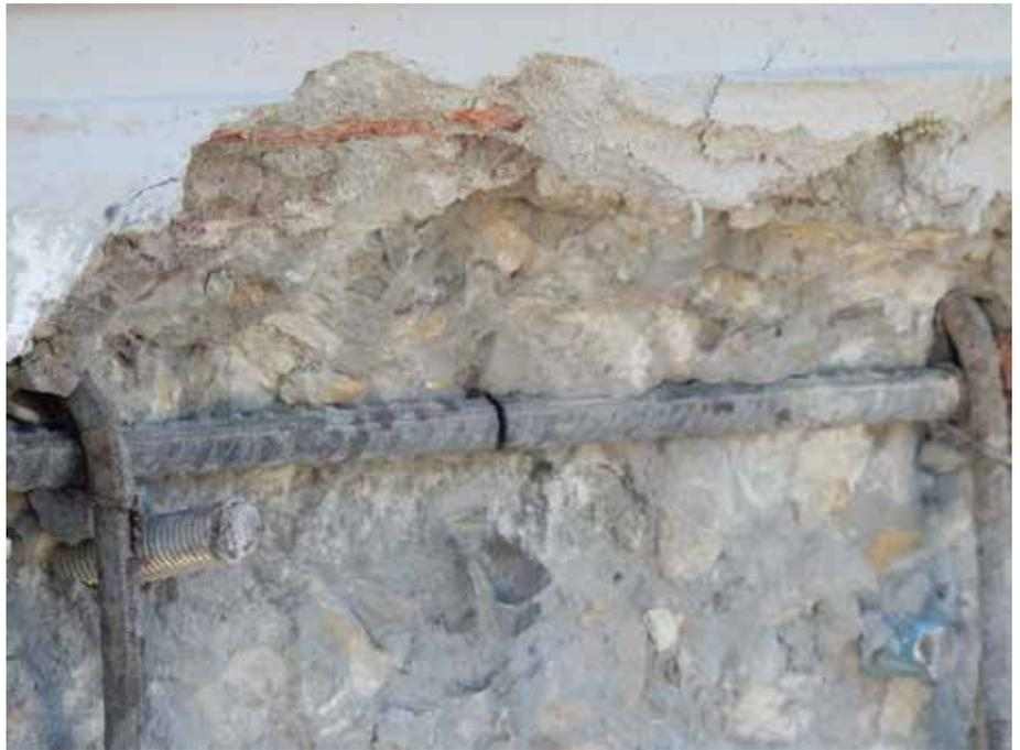
Foto 7. Detalle de corte de la barra existente
