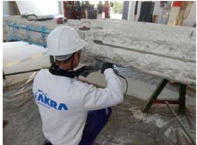
Foto 55. Lijado de las soldaduras
