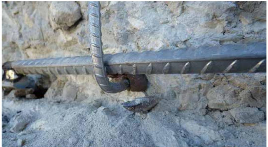
Foto 28. Detalle de colocación de estribo con anclaje químico
