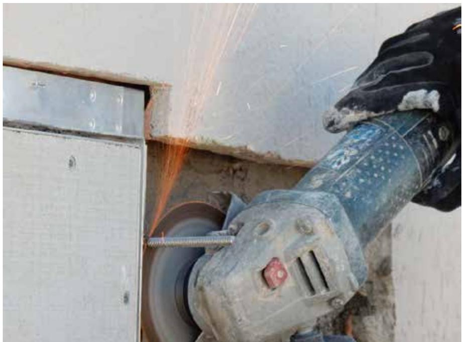
Foto 47. Eliminación de excesos de la varilla de anclaje
