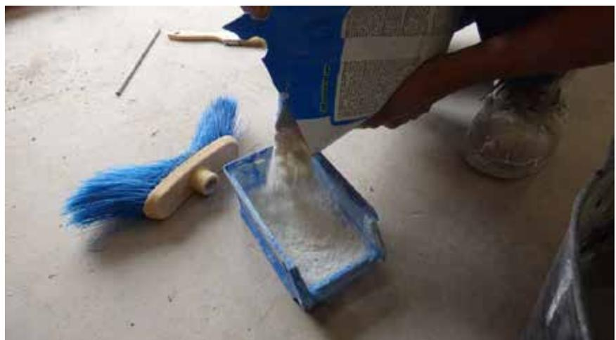
Foto 18. Preparación de la protección anticorrosión in situ
