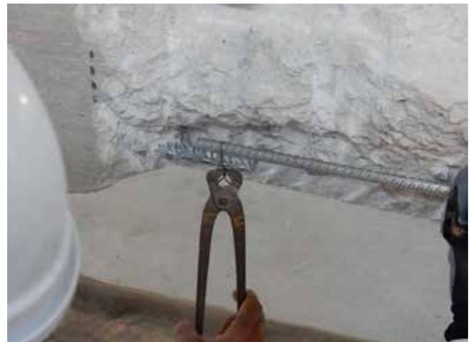
Foto 45. Presentación y anclaje de la barra sobre anclajes
