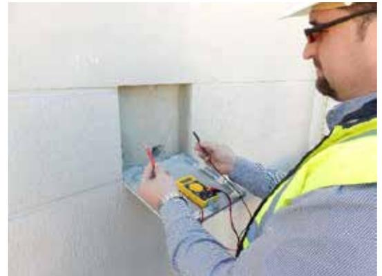
Foto 56. Comprobación de conexión eléctrica
