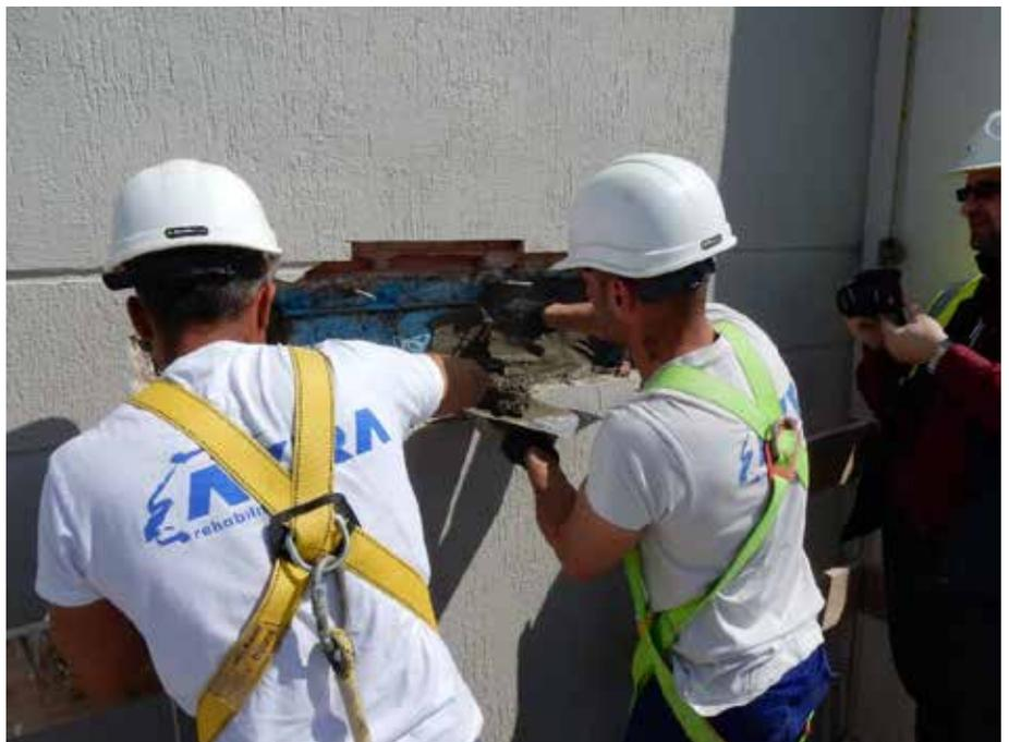
Foto 33. Aplicación de mortero de reparación
