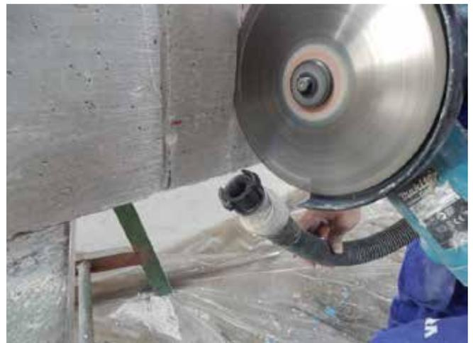
Foto 83. Corte del hormigón. Particular de la aspiración
