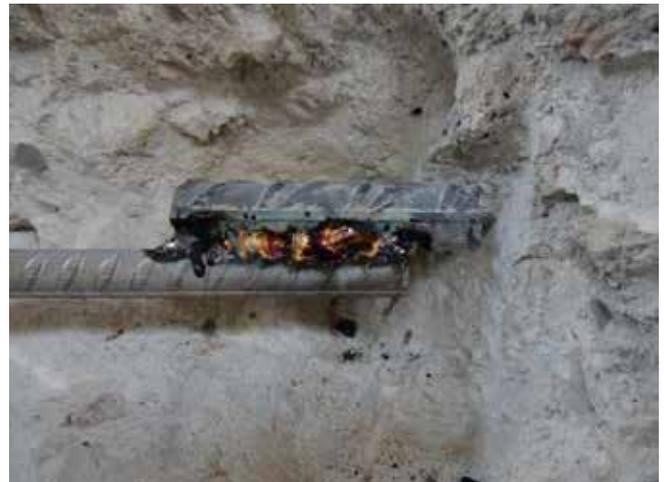
Foto 50. Detalle tras la soldadura
