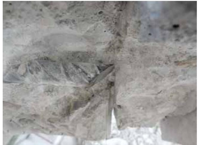
Foto 106. Tratamiento del corte de las armaduras
