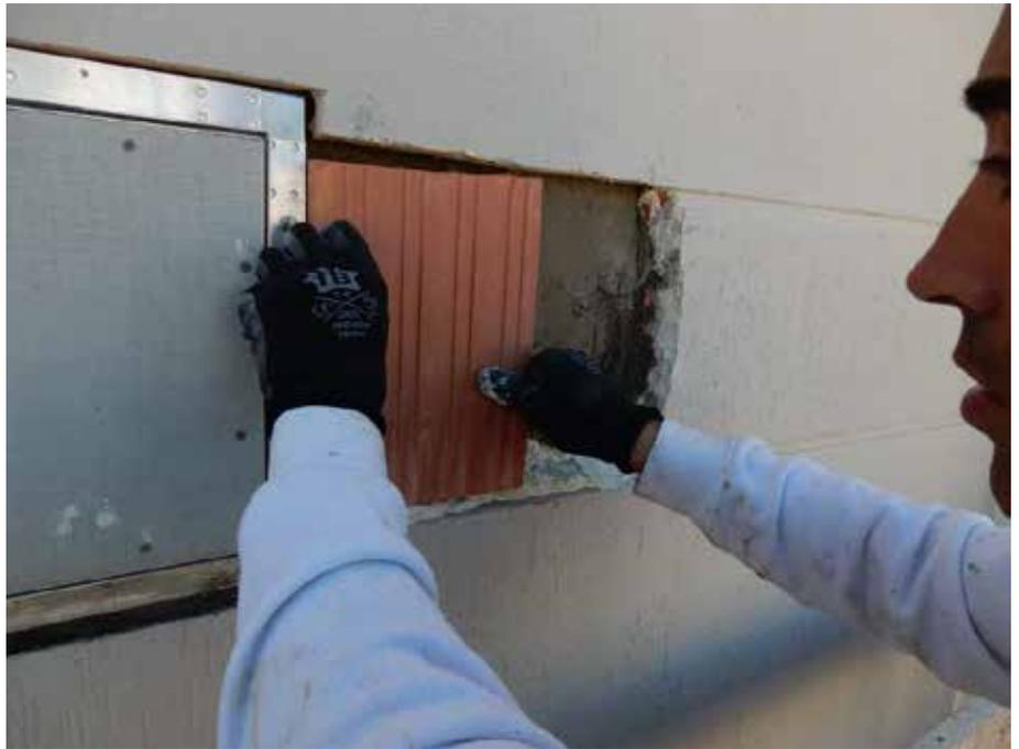
Foto 50. Forrado de ladrillo en frente de forjado reparado
