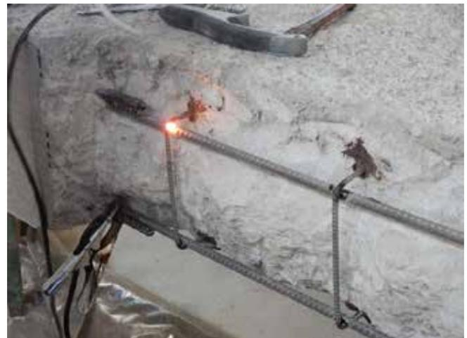
Foto 69. Punto de soldadura entre armadura y estribos
