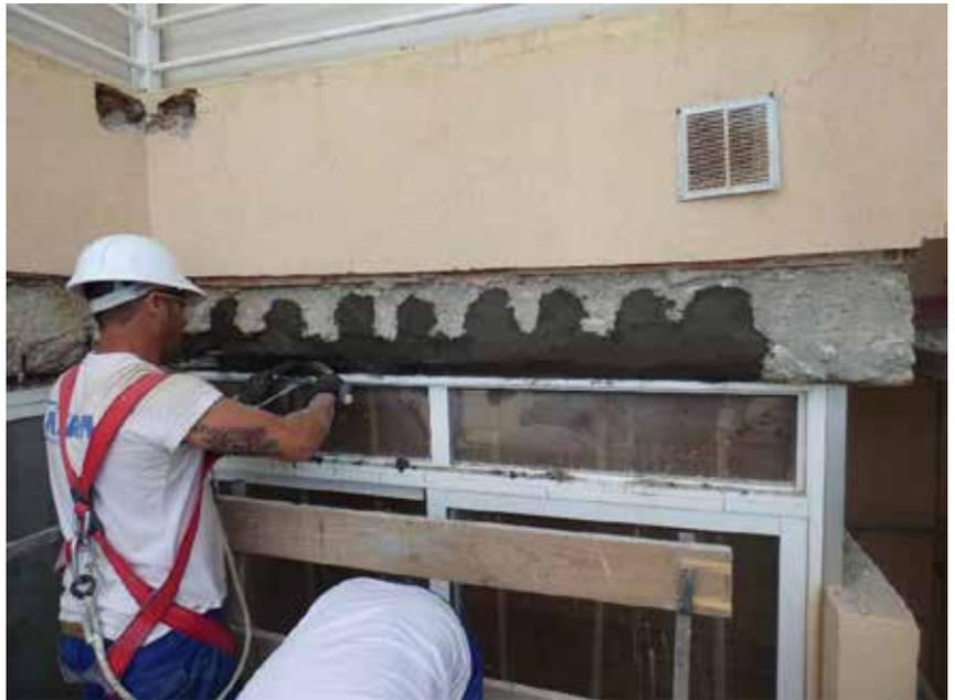
Fig. 5 Reconstrucción de volúmenes con mortero de reparación
