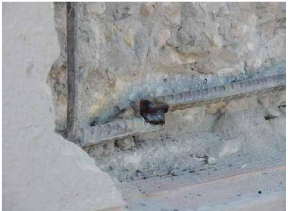
Foto 20. Pruebas iniciales de soldadura y tipos de solapes
