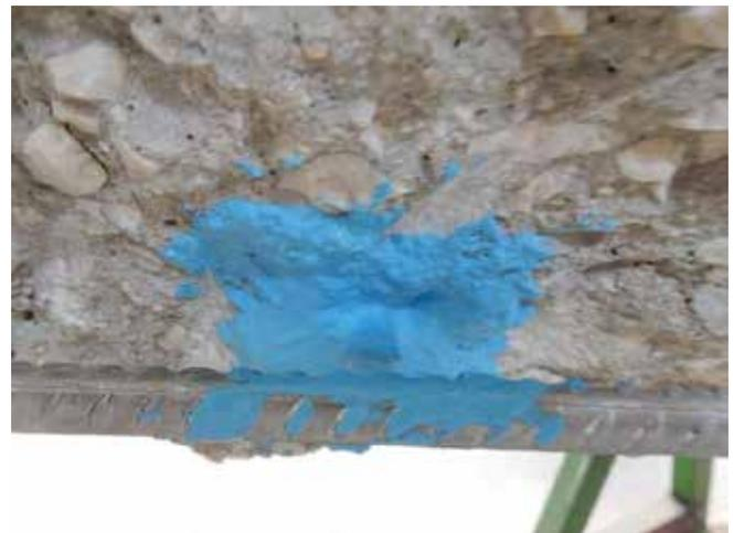
Foto 75. Detalle aplicación protección anticorrosión
