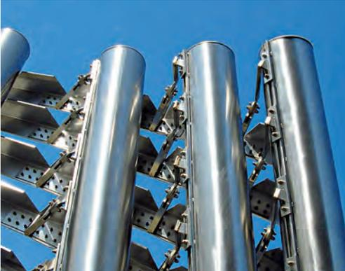
eine geschwungene Konstruktion aus nicht-rostendem Stahl die dahinterliegende, vollständig verglaste Fassade vor Sonneneinstrahlung im Sommer und kalten Winden im Winter.
