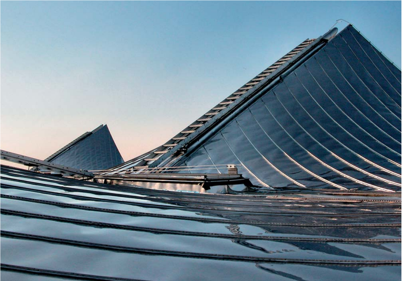
Die Dachlandschaft des Justizgebäudes wirkt wie eine durch Wellen bewegte Wasserfläche.
