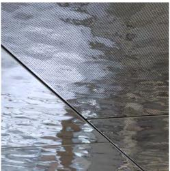
Die nichtrostenden Stahlbleche der Deckenverkleidung sind teilweise mit 16 % freiem Lochquerschnitt und eingelegtem Akustikvlies ausgeführt.
