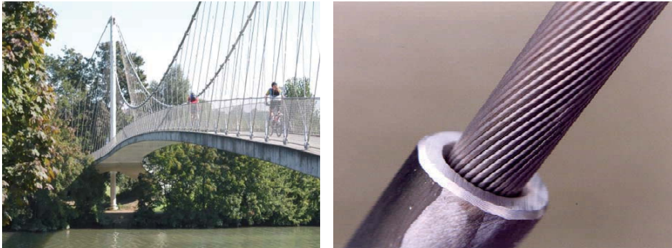
Figura 1. Aplicación de cordones AIAR externos expuestos a la atmósfera: Pasarela Max-Eith-Stern, Stuttgart, Alemania (izda.) y detalle de tendón (dcha.).
