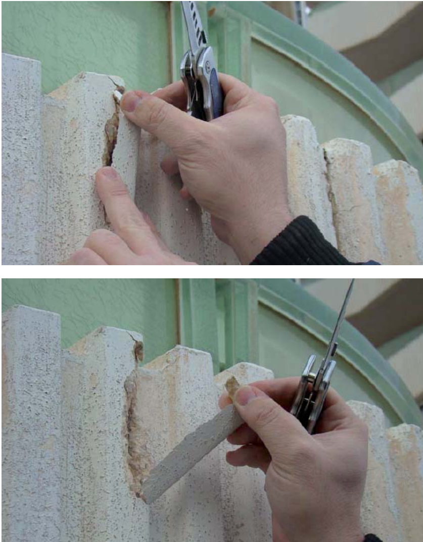
Figura 11 Grietas verticales en las crestas de los aplacados.
