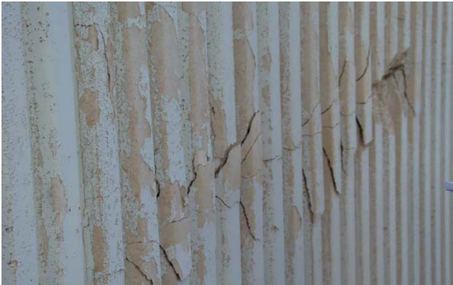
Figura 8 Grietas en forma de cuñas coincidentes con la armadura principal (I).
