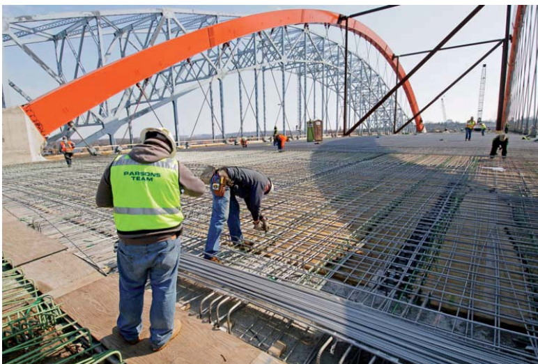
Figura 6 Puente TH 61 Hastings, Minesota, con armaduras de acero inoxidable dúplex tipo 1.4362 (Fotografía cortesía de CEDINOX).
