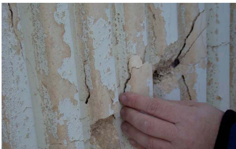
Figura 9 Grietas en forma de cuñas coincidentes con la armadura principal (II).
