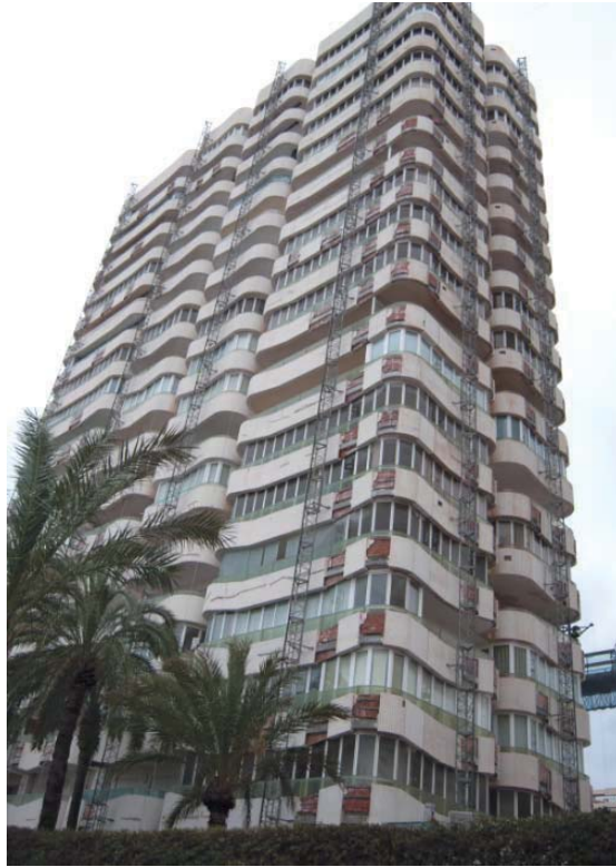
Figura 3 Vista frontal de una de las torres durante los trabajos de rehabilitación.
