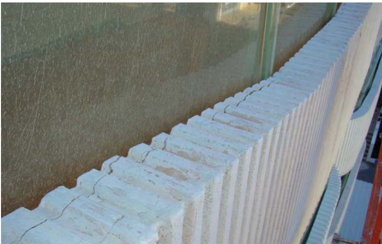
Figura 13 Grietas en la repisa superior de los aplacados.
