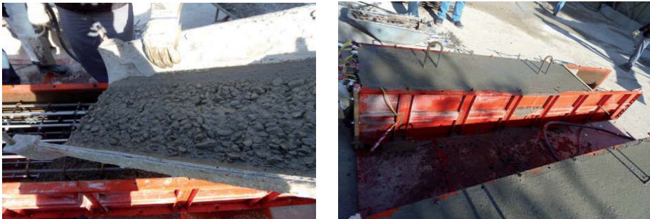
Figura 9 Hormigonado y fraguado de los Bartolos.
