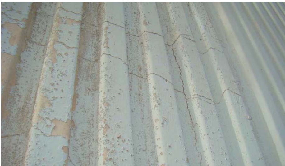
Figura 7 Fisuras horizontales de directriz recta.
