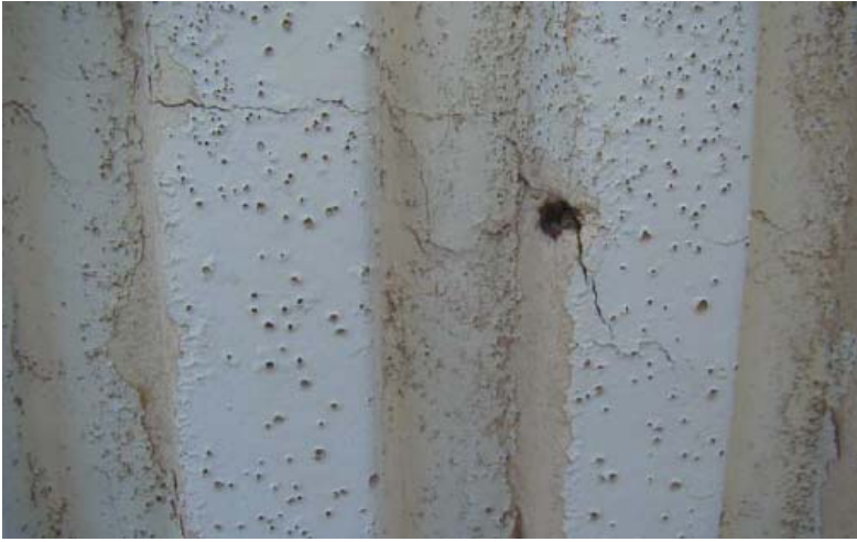
Figura 12 Deterioro de la pintura que se aplicó sobre los aplacados.
