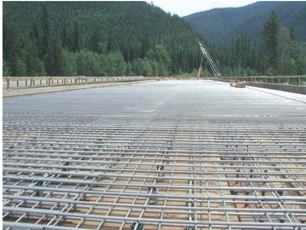
Figura 5 Puente de carretera en Montana sobre el río Flathead con armaduras de acero inoxidable (Foto cortesía de CEDINOX).
