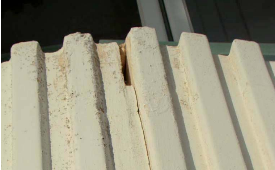
Figura 6 Fisuras verticales en las juntas de mortero entre las placas.
