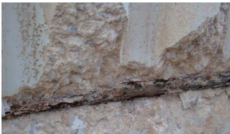
Figura 10 Grietas en forma de cuñas coincidentes con la armadura principal (III).
