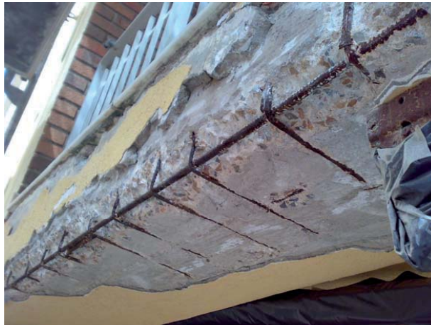
Figura 1 Corrosión de armaduras en un edificio próximo a la costa.
