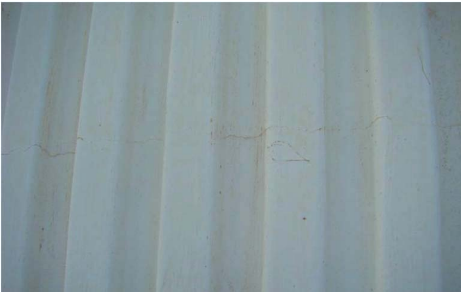
Figura 5 Fisuración antigua en los aplacados de fachada.
