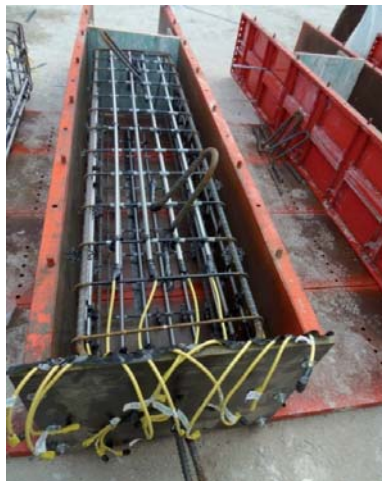
Figura 8 Colocación de la estructura en el molde.
