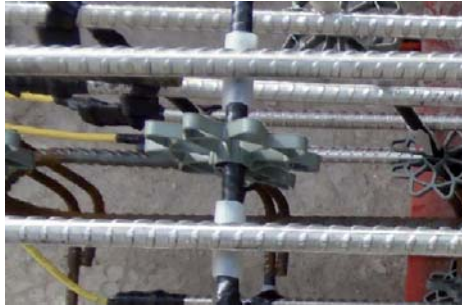
Figura 7 Aislamiento de las barras de acero inoxidable.
