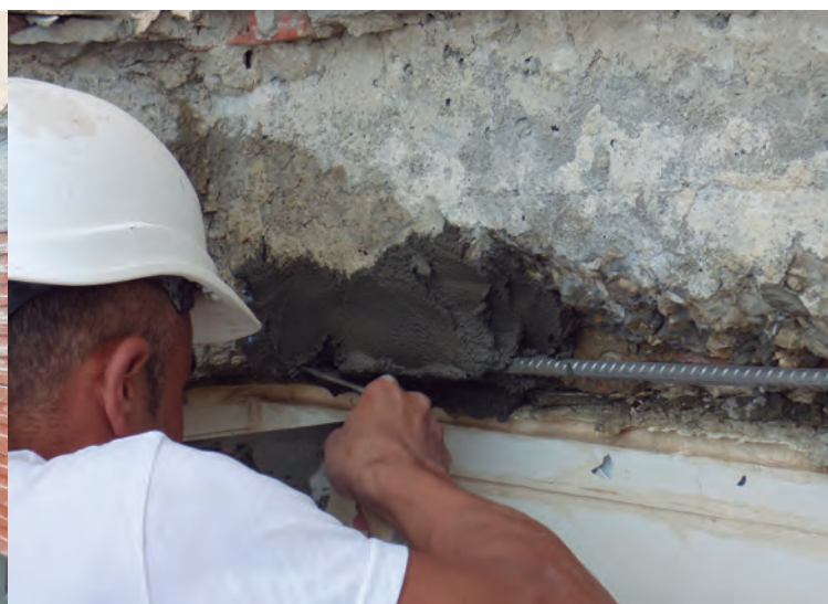
Figura 8: Retacado y regeneración de volumen tras colocación de barra de acero inoxidable
