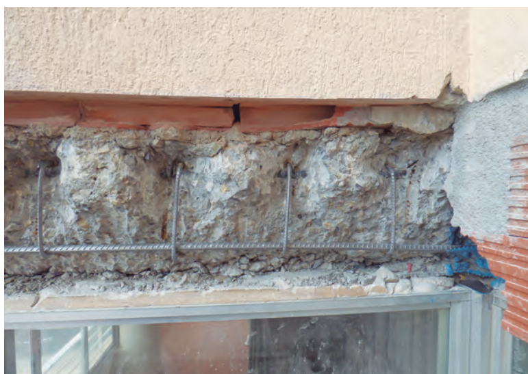
Figura 7: Colocación de armadura corrugada de acero inoxidable
