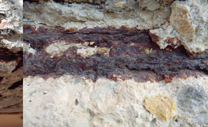
Figura 6: Fisuras en cara inferior de frente forjado
