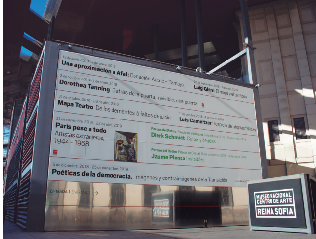
Museo Reina Sofía de Madrid. Plancha de acero inoxidable pegada a plancha de acero inoxidable con adhesivo epoxi 3M™ Scotch-Weld™ 7260 B/A (año 2004)
