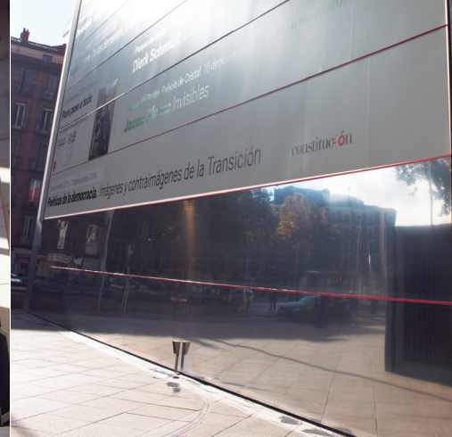
Museo Reina Sofía de Madrid. Plancha de acero inoxidable pegada a plancha de acero inoxidable con adhesivo epoxi 3M™ Scotch-Weld™ 7260 B/A (año 2004)
