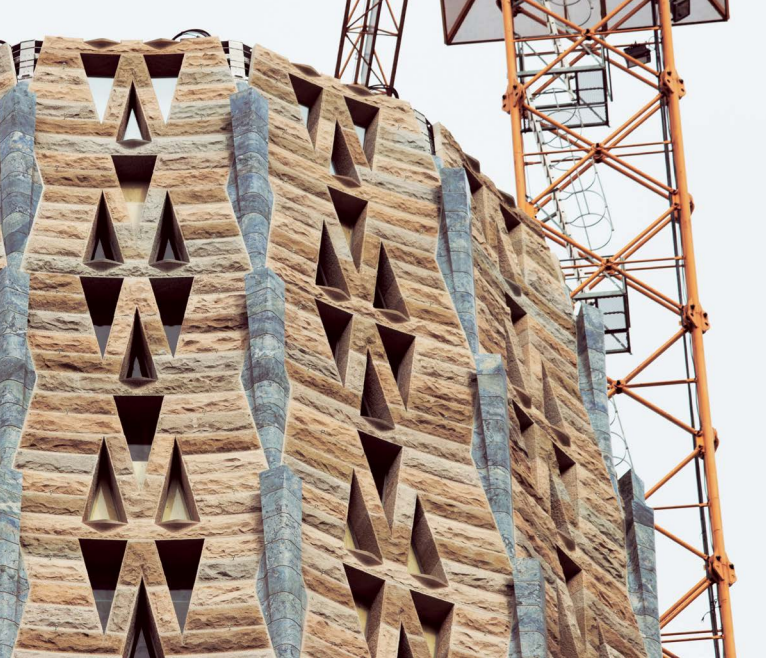
Torre "Mare de Deu" hasta el nivel 9 instalado en la basílica
