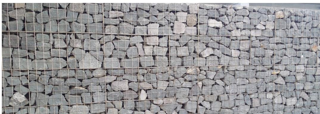
vientos alisios cargados de cloruros y otras sales, con una clasificación ambiental según ISO 9223 de C5 para la ejecución de los muros perimetrales de las instalaciones, así como mobiliario de jardinería (banco) se emplean gaviones de malla electrosoldada conformes a la UNE EN 10223-8, en aleación de acero inoxidable AISI 316.
