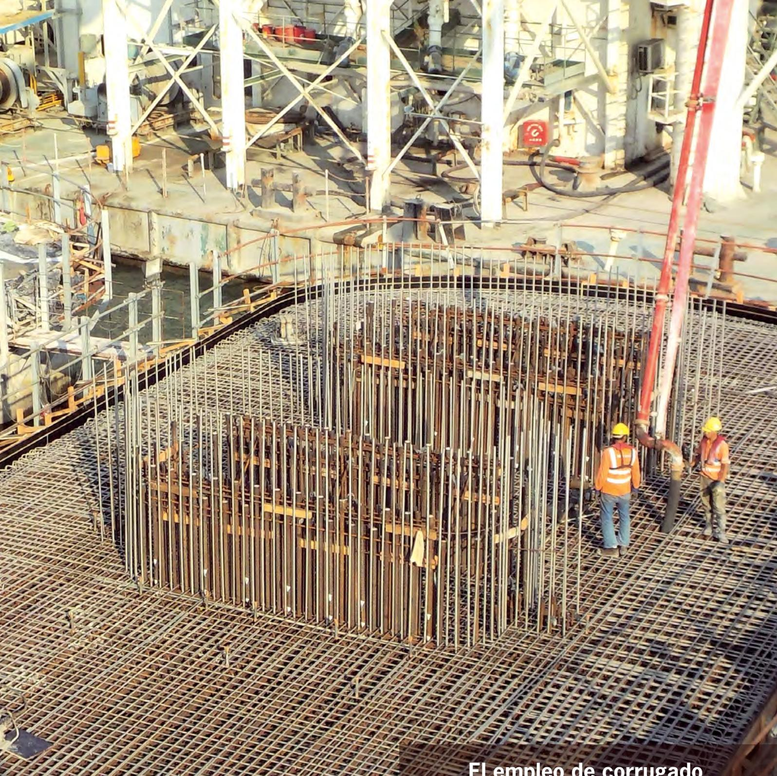
**El empleo de corrugado de acero inoxidable en combinación con corrugado de acero al carbono, en estructuras de hormigón armado, está incluido en el Código Estructural y es una práctica habitual.**
